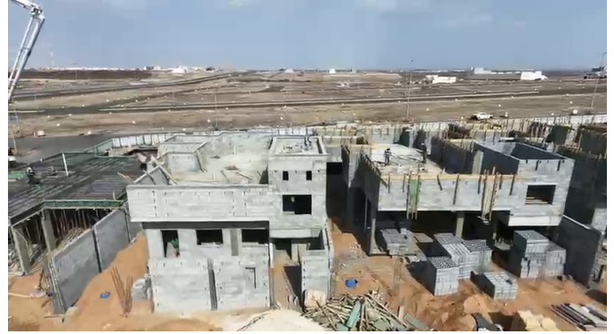
المباني أثناء التنفيذ
