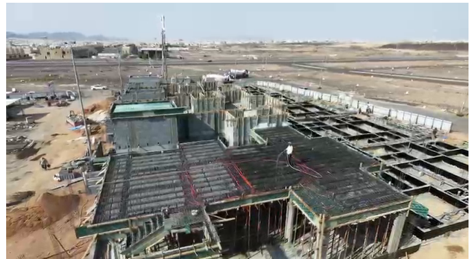
أعمال تنفيذ الأسقف
